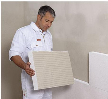
Multipor termoizolacione ploče na koje je ranije nanešen sloj maltera postavljaju se na površinu zida, dobro se pritisnu i malo povuku - pritisnuti i pomeriti po površini zida do druge ploče. Na taj se način postiže dobro prijanjanje za podlogu.
