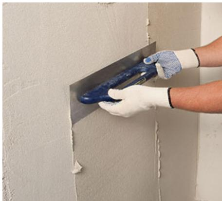
Pripremljena Ytong Glet masa se nanosi na čistu i suvu površinu prethodno obrađenu Ytong Plasterom. Masa se nanosi u dva sloja. Debljina slojeva je oko 1-2mm i zavisi od ravnosti površine. Nanošenje se vrši ručnim alatom za gletovanje. Osušena površina se brusi finim brusnim papirom i posle toga je spremna za nanošenje boje.
